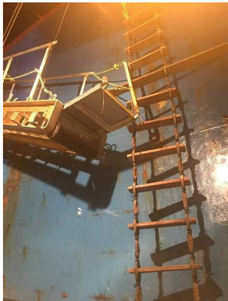
non compliant combination
